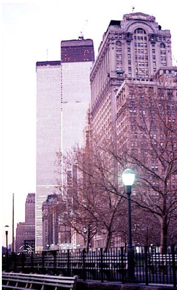
図4 最上部が建築中の世界貿易センター
